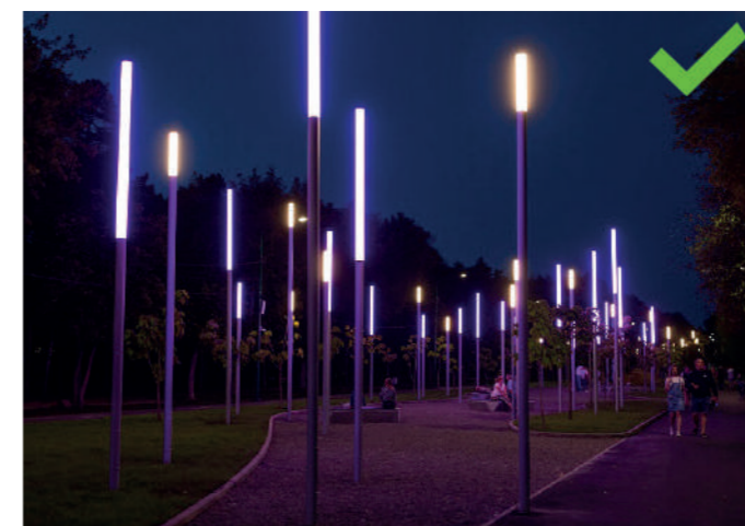
Освещение на опорах.
