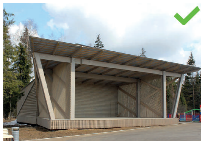
Интересная выразительная деревянная конструкция.
