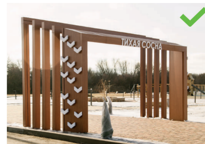
Входная группа на набережной реки Тихая Сосна в городе Острогожск.
